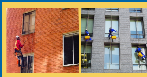
* Lavado y mantenimiento de fachadas .
