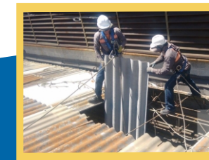
* Mantenimiento de canales, de cubiertas, bajantes cambio de tejados .
