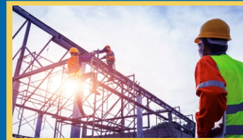
* Trabajos en alturas
